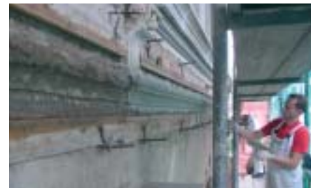
Das Barthelmes-Team bei Gesimszugarbeiten an einer bekannten Leipziger Villa.
