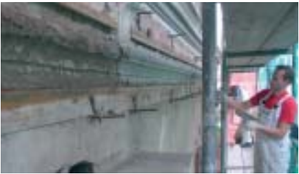
Das Barthelmes-Team bei Gesimmsugarbeiten an einer bekannten Leipziger Villa.
